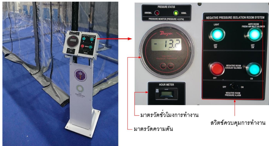
รูปที่ 2 ภาพแสดงแผงควบคุมของห้องแยกโรคความดันลบแบบที่ 2
