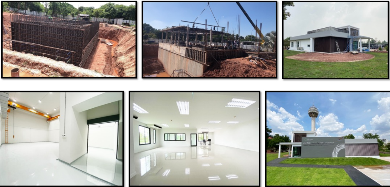
รูปที่ 3 ภาพแสดงการก่อสร้างอาคารวิจัยประยุกต์
