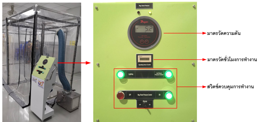
รูปที่ 1 ภาพแสดงแผงควบคุมห้องแยกโรคความดันลบแบบที่ 1
