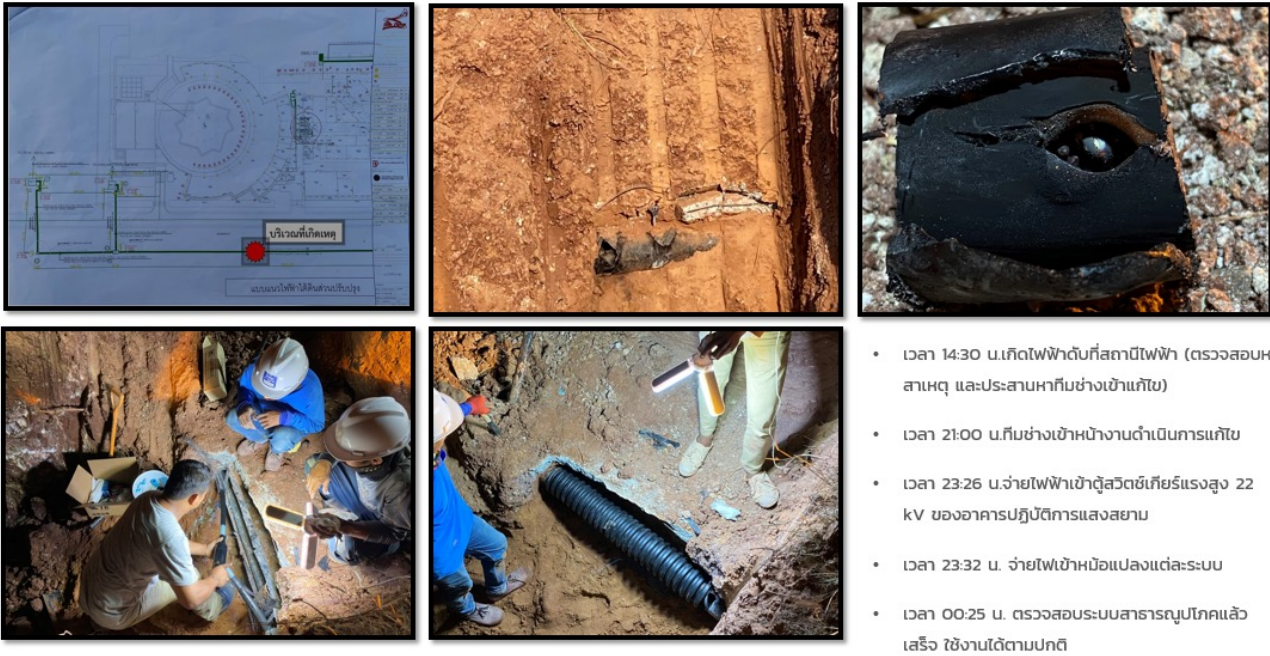
รูปที่ 4 ภาพแสดงการแก้ไขระบบจ่ายไฟฟ้าแรงสูงขัดข้อง
