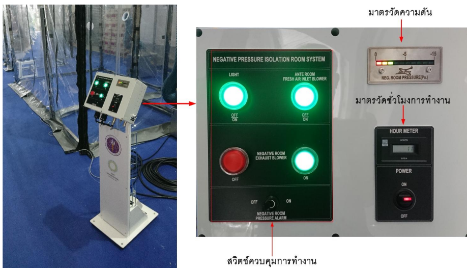
รูปที่ 3 ภาพแสดงแผงควบคุมห้องแยกโรคความดันลบแบบที่ 3
